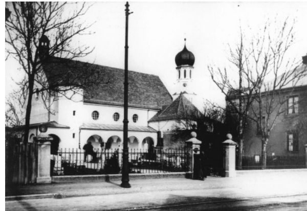
Blick auf Langschiff und Loggia der neuen Kirche, im Hintergrund der barockisierte Turm der alten Kirche. Aufnahme von Georg Petten-dorfer, 1915
